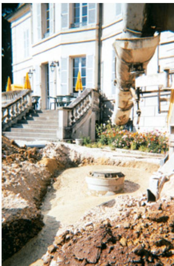
LB Remplissage est un béton fluide et autocompactant destiné au remplissage de tous types de cavités.
